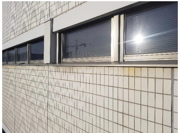
Kuva 16 Ruostevalumajälkiä itäjulkisivulla
