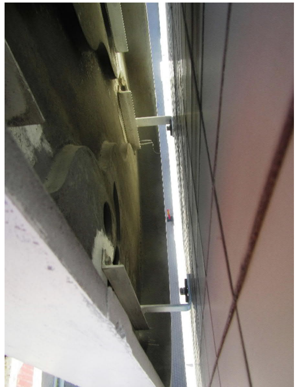
Kuva 21 Eteläpäädyn vaakunan kiinnitykset.
