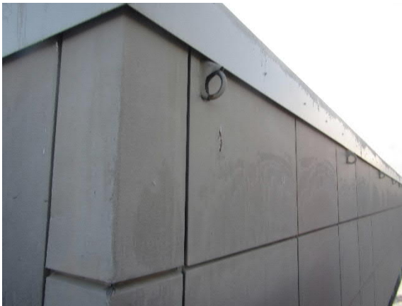
Kuva 26 Peltikasettijulkisivua
