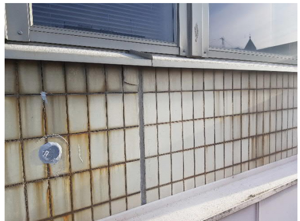
Kuva 8 Ruostealumia länsijulkisivulla
