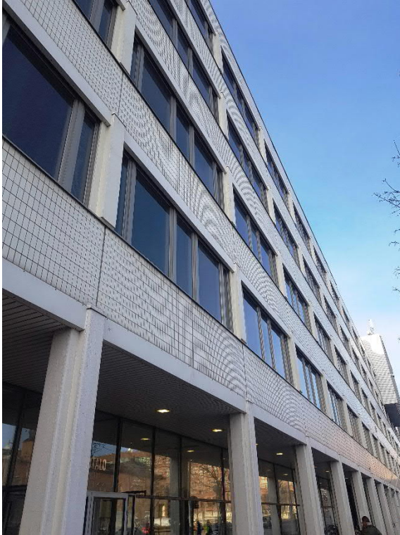
Kuva 1 Klinkkerilaattainen julkisivu.
