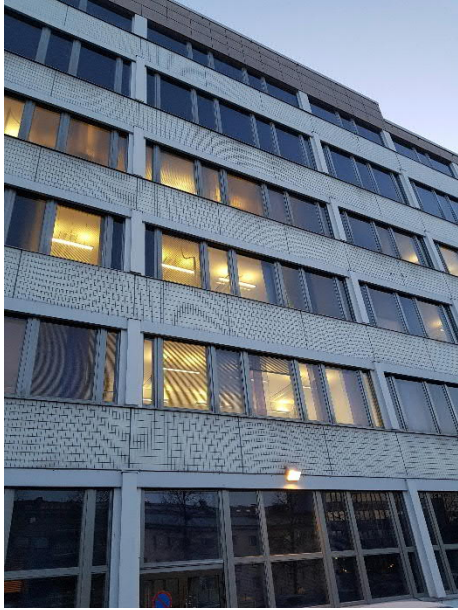
Kuva 13 Valumajälkiä länsijulkisivulla
