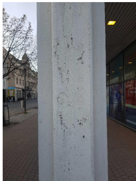
Kuva 29 Epätasaisuutta pilarin pinnalla
