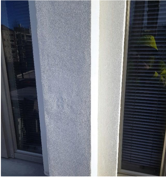
Kuva 3 Ikkunaväleissä on maalatut betonipilasterit.
