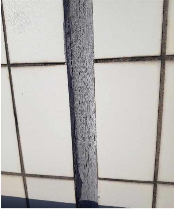
Kuva 9 Elementtisaumoissa on halkeilua.
