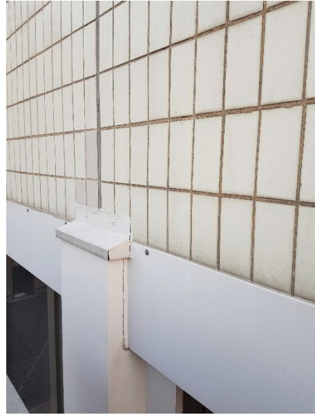
Kuva 4 Pilasterien päälle on asennettu pellitys
