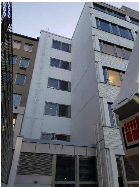
Kuva 28 Pohjoisjulkisivun maalattuja elementtejä.
